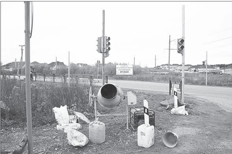
При повороте на село Ягул в Завьяловском районе (один из очагов аварийности) по просьбам автомобилистов и общественников установлен светофор
