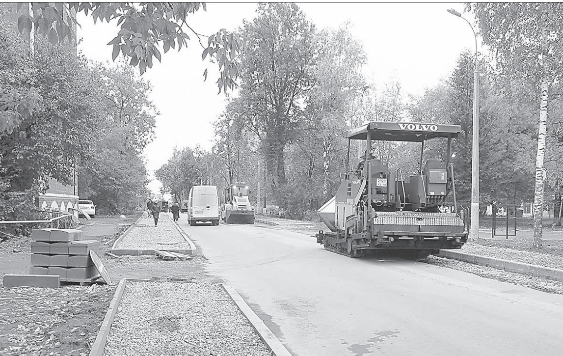
Переулок Широкий в Ижевске, не видевший ремонта несколько десятилетий, в 2017 году ремонтируют на средства, сэкономленные в рамках торгов
